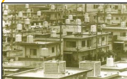
給水制限時の自衛手段の屋上タンク
