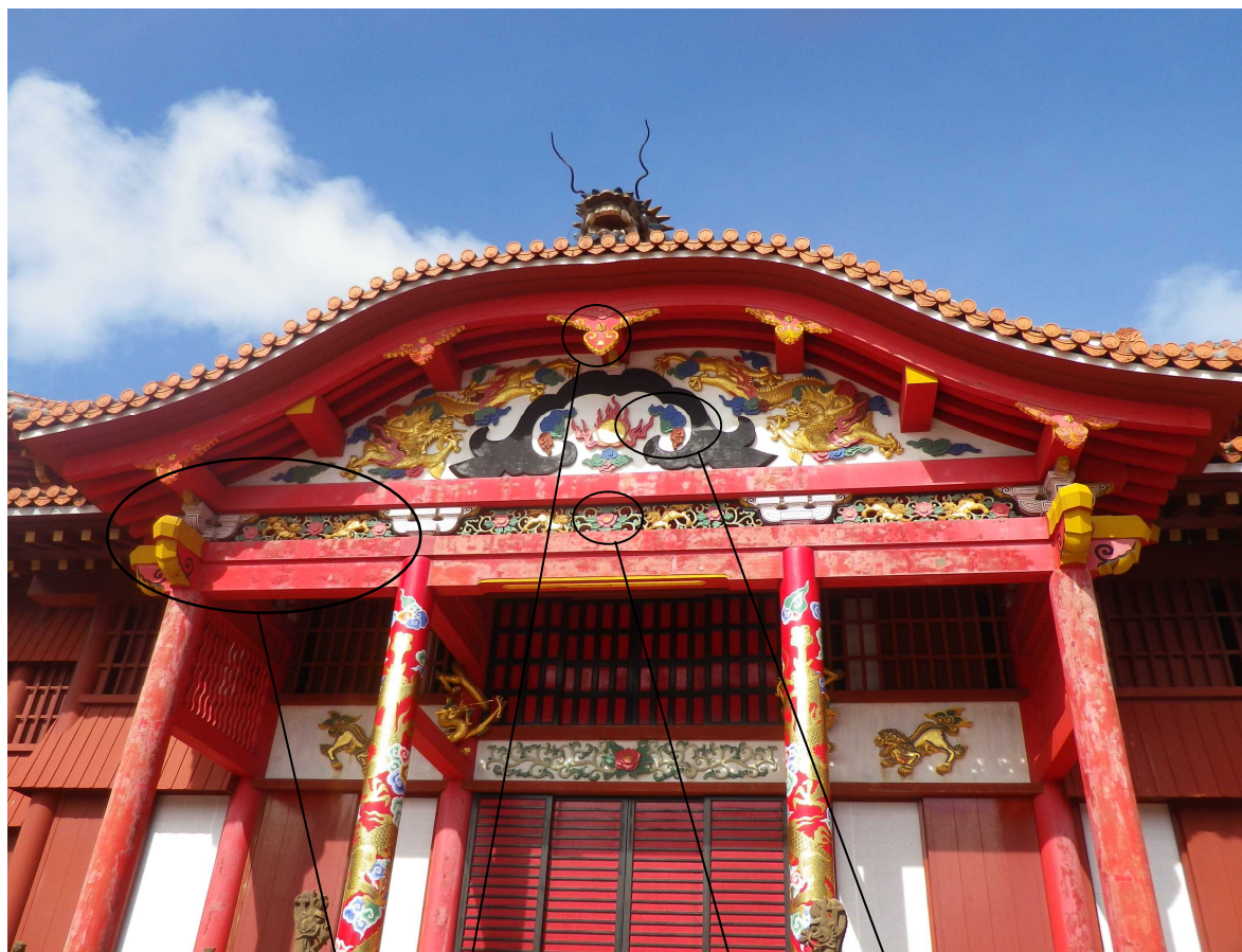
【 首里城正殿正面側（中央部分）の漆塗装・彩色の劣化、金箔の剥がれの状況 】
