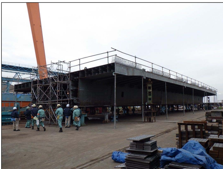
(鋼桁仮組状況)
