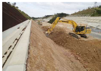
MCバックホウによる法面整形 現在丁張無しで施工
