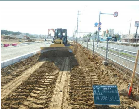
MCブルドーザによる盛土
