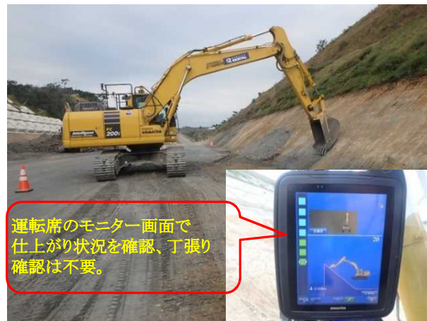
ICTバックホウによる切土法面整形
