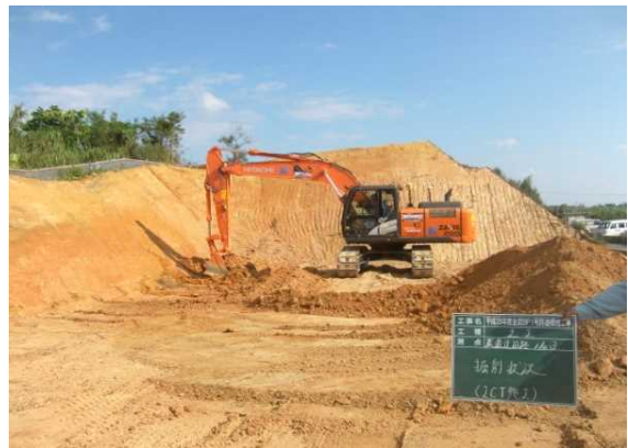
MCバックホウ掘削・法面整形状況
