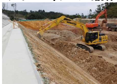
MCバックホウによる法面整形
