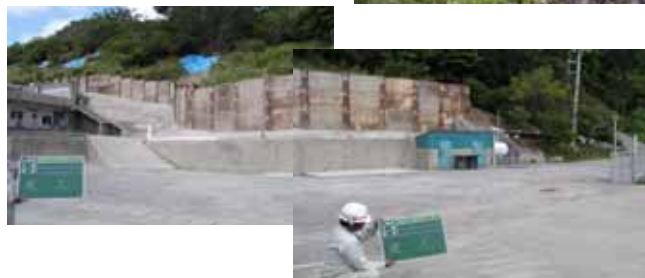
仮設施工後の状況
