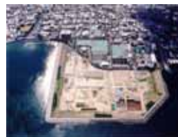
宜野湾浄化センター
