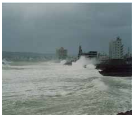
台風による越波状況
