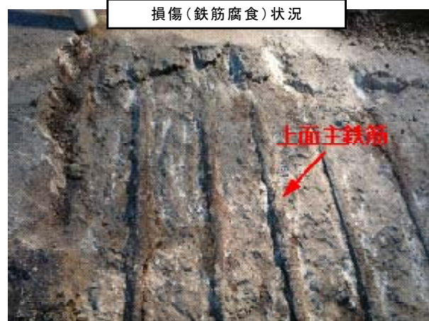
損傷(鉄筋腐食)状況
