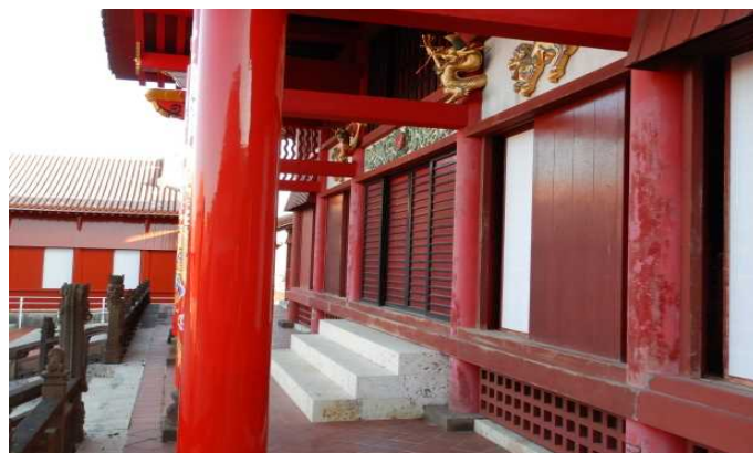
【向拝内側柱、敷居 漆劣化】
