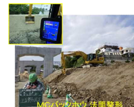
MCバックホウ 法面整形
