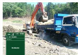
積み込み作業の様子（内部モニターに累計重量が表示される）
