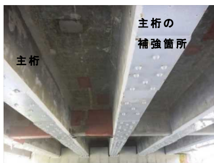
写真② 橋下面の補強状況
