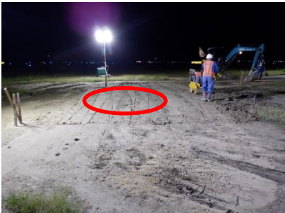
埋戻し (碎石による埋戻し)
