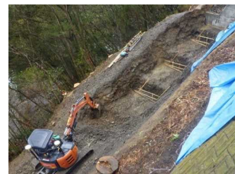
ICT建機による掘削作業
