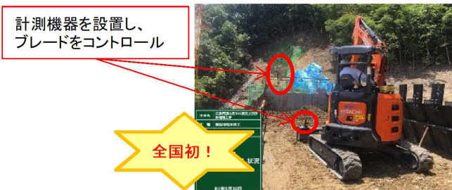
【ICT建機による本堤内部材敷均し】
