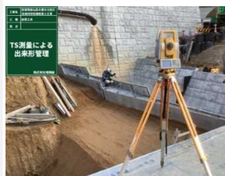
【構造物TS測量状況】
