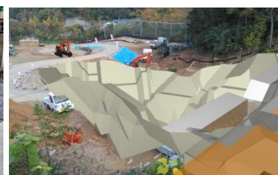
【掘削・床掘AR】
