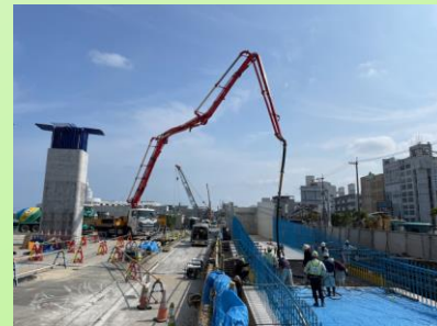
コンクリート打設
