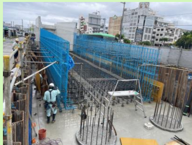
擁壁鉄筋組立状況
