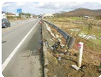
ガードレール・ 標識等の損傷
