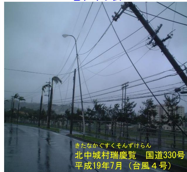
電柱倒壊
