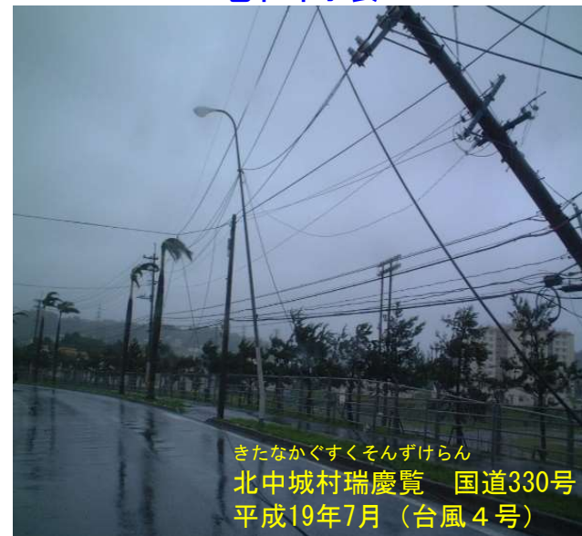
電柱倒壊
