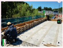
【立会状況（地覆型検測）】
