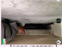
【立会状況（支承部確認）】
