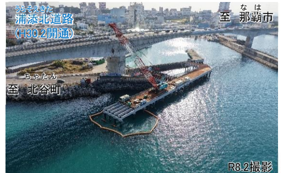
【写真①】起点側から望む
