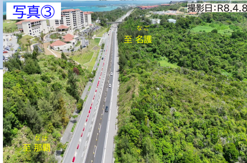
写真③ 3号橋より起点側を望む
