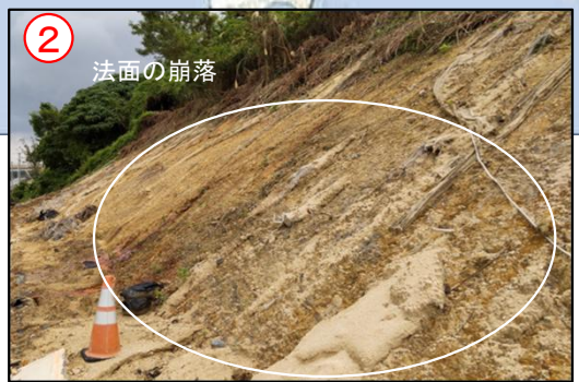
OIST交差点付近の法面(変状・対策状況)
