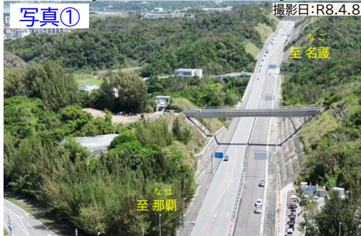
写真① 起点側を望む
