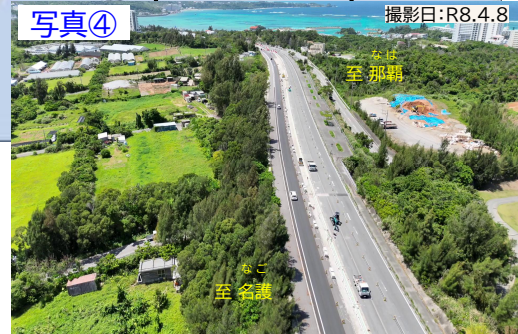
写真④ 3号橋より終点側を望む
