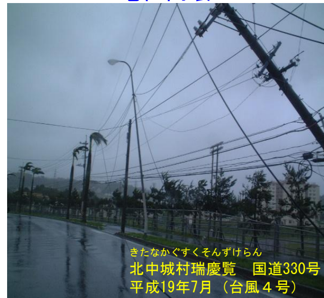
電柱倒壊
