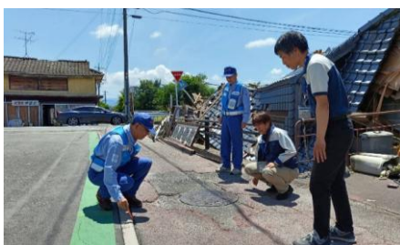
道路の被災状況調査(八代市)
