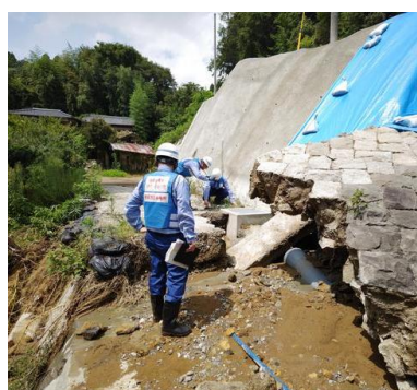
道路法面の被災状況調査 (千葉市)
