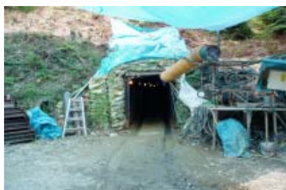
ダムサイトにおける地質調査(横坑)
