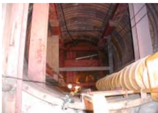
ダムサイトにおける地質調査(竖坑)
