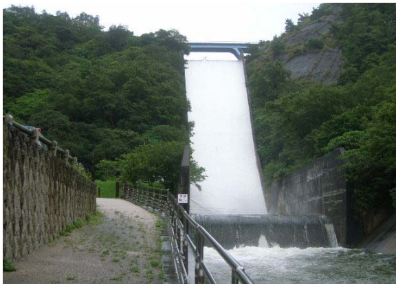
福地ダム 越流の状況
