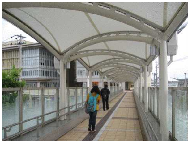
モノレール旭橋駅周辺地区 第一種市街地再開発事業 (那覇市)
