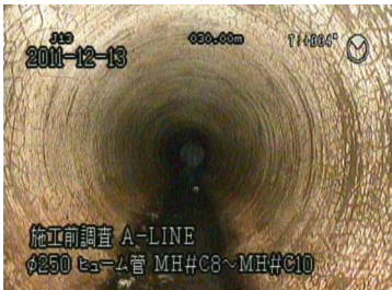
下水道管更生 老朽化した下水道管
