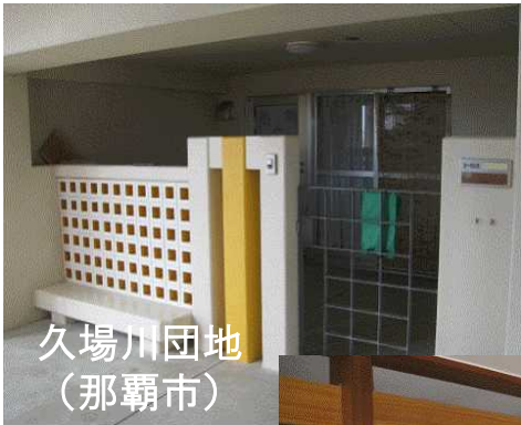
通風性の確保による暑さ対策 花ブロックの設置
