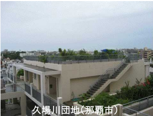
屋上緑化による断熱対策
