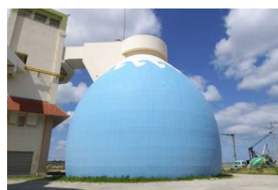
汚泥消化タンク
