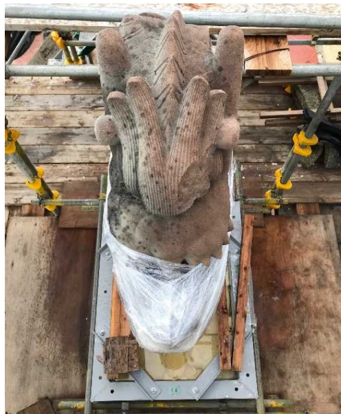
養生作業（ウレタンによる固定）中の大龍柱（吽形）
