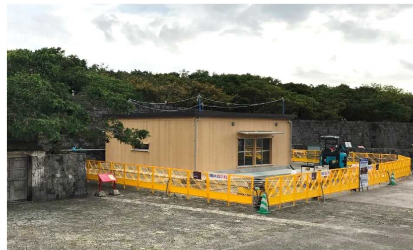
下之御庭に整備中の補修作業場
