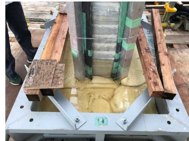
養生作業（ウレタンによる固定）中の大龍柱（吽形）
