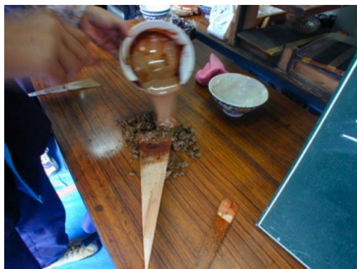
正殿の補修時（H18～H22年度）に、引込地材に新たに二ービ層（砂岩層）の土を使用 （左：調合の様子、右：補修作業の様子）
