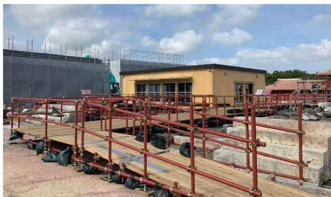
正殿遺構の覆屋と公開用仮設デッキ
