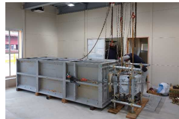
補修作業場へ搬入された大龍柱
