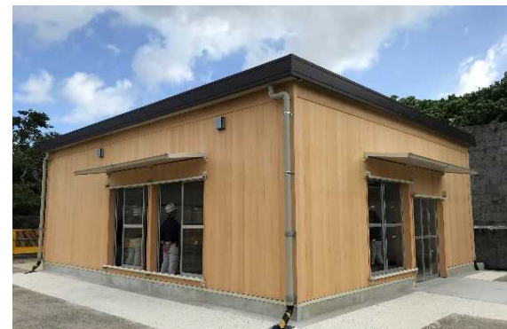
下之御庭の仮設補修作業場
