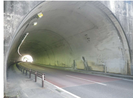
▲トンネル照明LED化 (国道330号浦添市西原)
