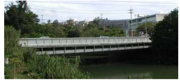
比謝橋 (昭和28年完成 供用年数71年 国道58号)
