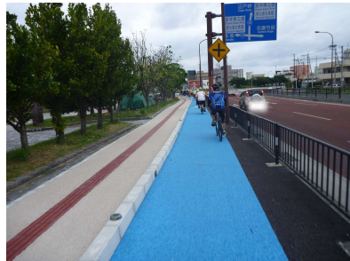
▲自転車道整備状況(国道58号 名護市)
