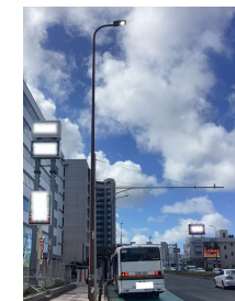
▲更新した道路照明 (LED照明)
