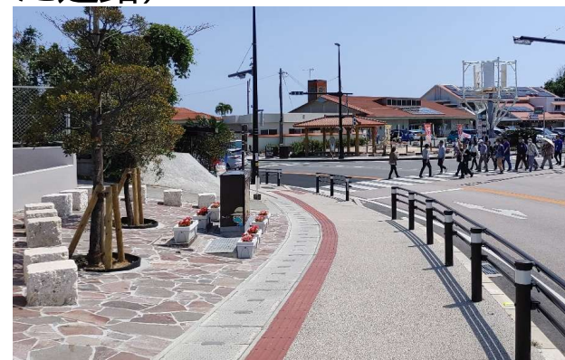
▲歩道の白舗装状況②(国道331号南城市)
