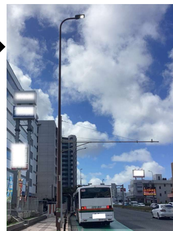
▲更新した道路照明 (LED照明)
