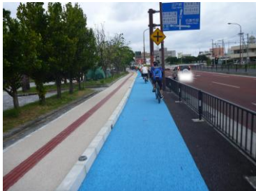
▲ 自転車道整備状況 (国道58号 名護市)
