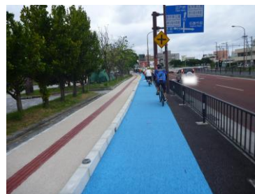
▲自転車道整備状況(国道58号 名護市)
