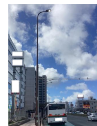
▲更新した道路照明 (LED照明)
