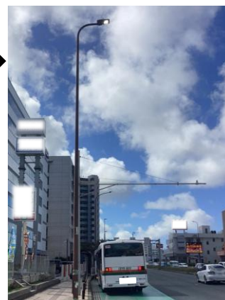
▲更新した道路照明 (LED照明)
