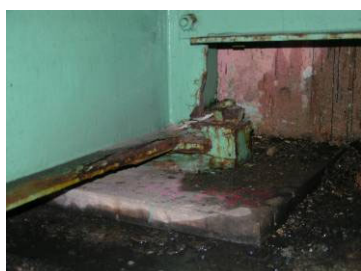
鋼桁の腐食による断面欠損状況
