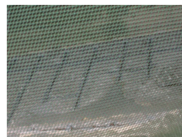
塩害による主桁コンクリートの剥離・鉄筋露出、ひびわれ
