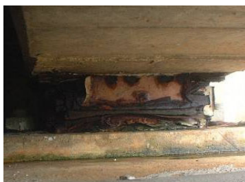
支承部の腐食状況 1
