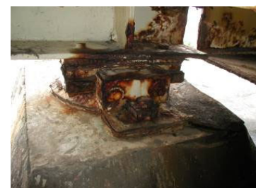
支承部の腐食状況 2
