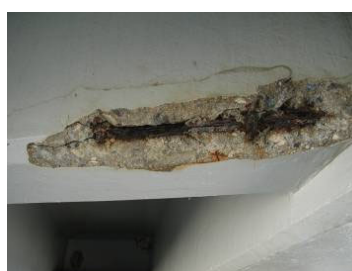
コンクリート T 桁の鉄筋露出状況
