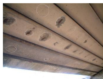
プレテン床版の鉄筋露出状況
