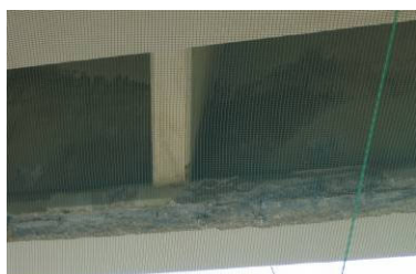
ポステン T 桁の鉄筋露出状況
