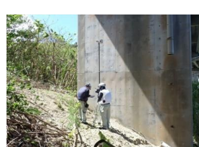
【ロボットカメラによる点検】
