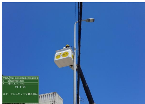
道路照明の電線管付属材料の撤去
