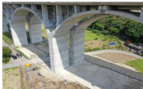
【対策後（RC巻き立て工法）】
