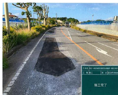
【ひび割れ補修後】
