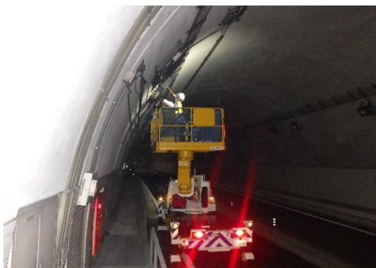
【トンネル点検車による点検】
