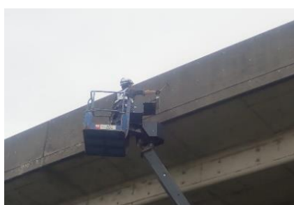
【コンクリート落下事故 防止のための点検】
