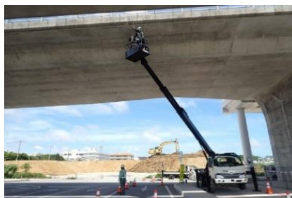
【高所作業車による点検】
