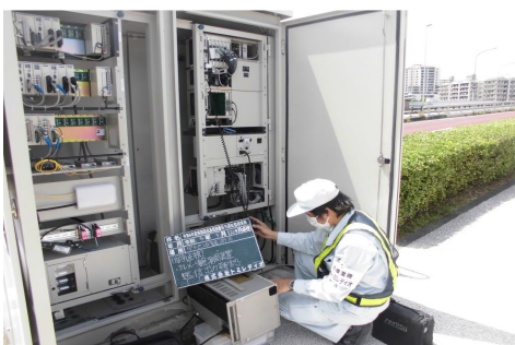
テレメータ観測局装置の点検
