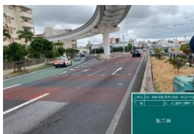
【わだち・カラー舗装の劣化状況】
