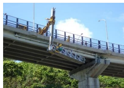
【橋梁点検車による点検】
