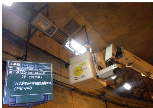
トンネル照明灯具の清掃
