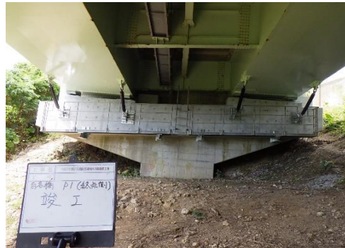
【対策後（落橋防止装置の設置）】
