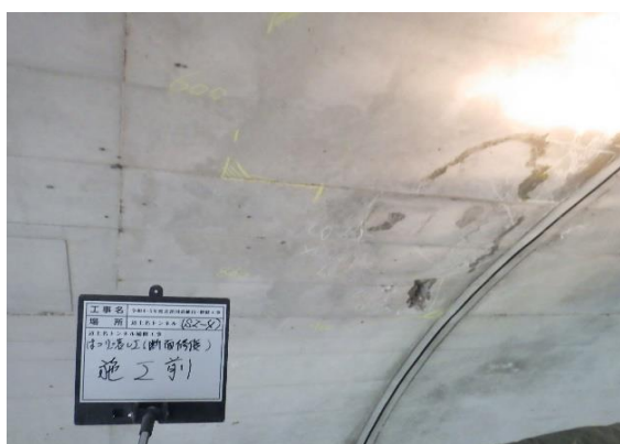
【補修前（コンクリート浮き・叩き落とし）】
