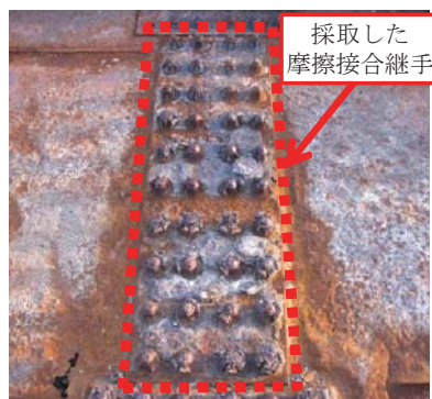
図2 採取した摩擦接合継手
