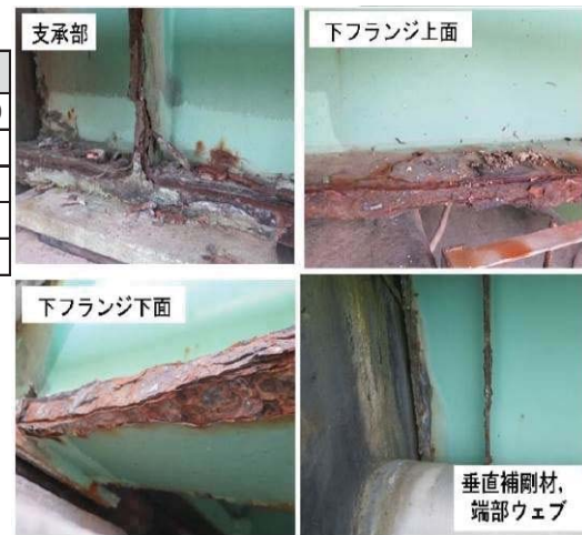
図 3 施工対象橋梁の腐食外観状況
