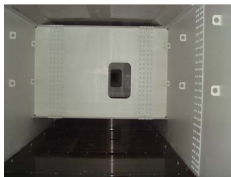
b) 防食デッキ設置部の内面塗装系の状況
