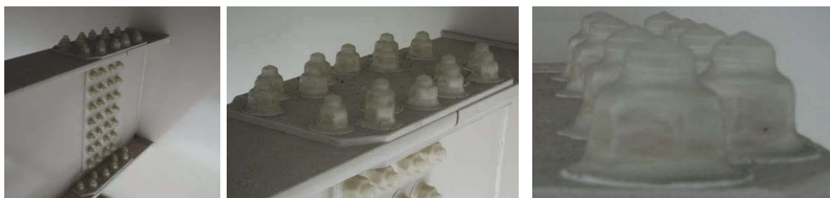
図-8 透明型ボルトキャップの外観状況の例（約 1 年 8 ヶ月経過）
