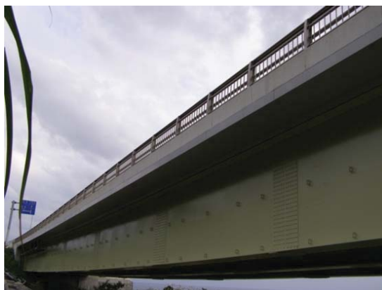
写真 2.3 単純鈹桁橋（3 主桁）
