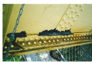
写真-7.3 損傷部のパテ塗付状況
