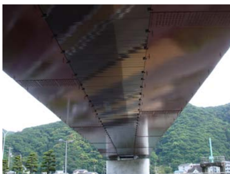
a) 桁下から見た外面塗装系の状況
