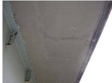
写真-5 吊り金具の腐食
