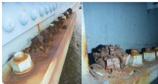
図1 高力ボルトの腐食例
