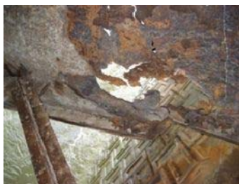
写真 護岸直上のウェブと下フランジ境界の腐食と破断
