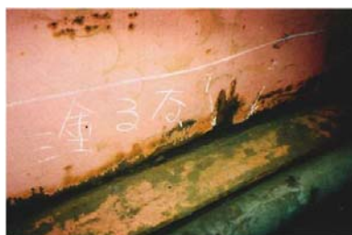
写真-7.1 主桁溶接部の腐食
