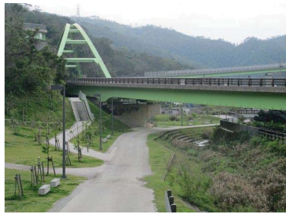
写真 2.2 鋼箱桁橋（鋼箱桁部を対象）
