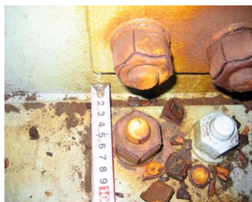
写真－1.5 高力ボルト継手部の狭隘部
