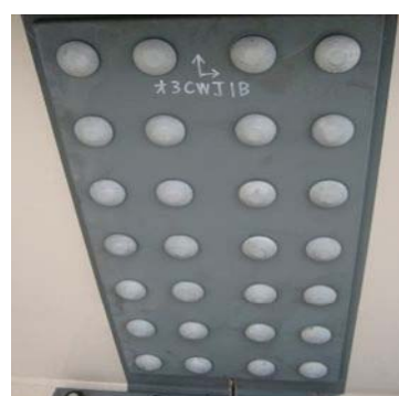
写真－２ 締付け状況（塗装前）
