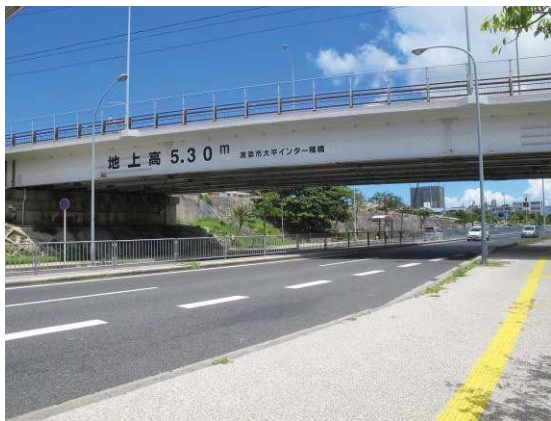
写真 2.1 単純鈹桁橋（6主桁）
