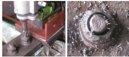
(a) コア抜き作業 (b) コア抜き後
