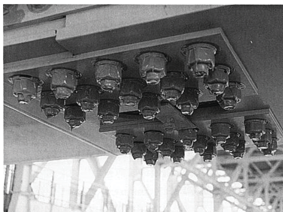
写真-6 実橋での塗装状況
