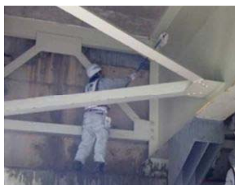
写真 モップによる洗浄状況
