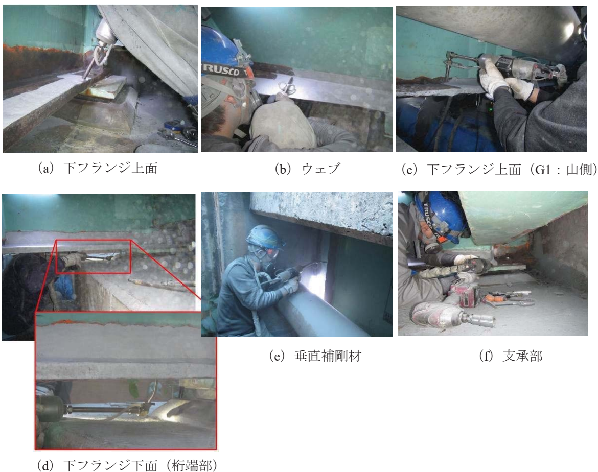
図 7 施工条件別の CS 施工状況
