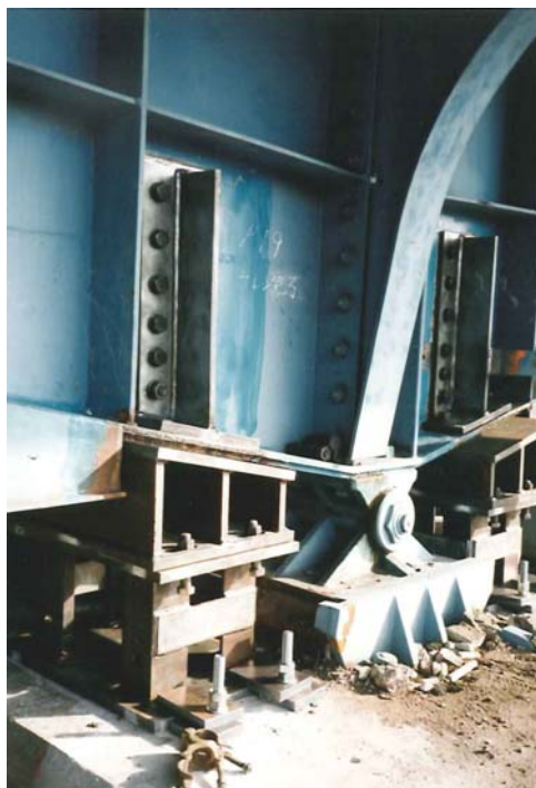
写真－7.6 支承交換時の主桁の補強
