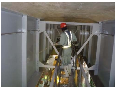
写真 高圧洗浄機による洗浄状況
