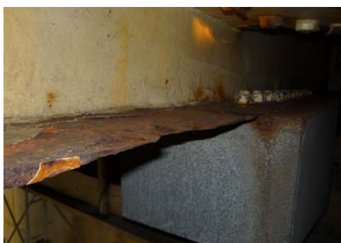
写真-4.1 桁内部下フランジェッジ部の腐食
