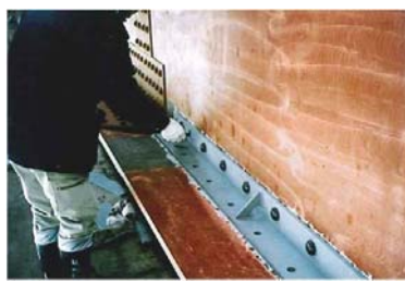
写真-7.2 補強材取付状況
