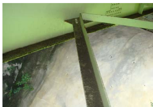
写真-4.2 桁内部下フランジ上面などの塵埃の堆積
