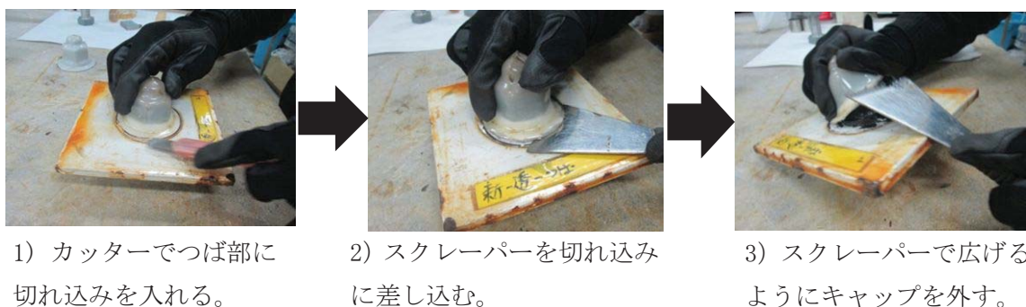
図-5 ボルトキャップの取り外し手順
