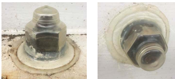
図-4 透明型ボルトキャップの外観状況（つばのみ接着、桁外面）
