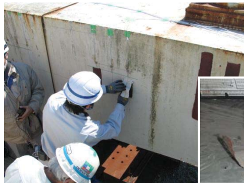
写真2 I H塗膜剥離工法の適用試験状況
