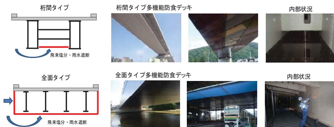
図2 多機能防食デッキ適用橋の断面と事例写真
