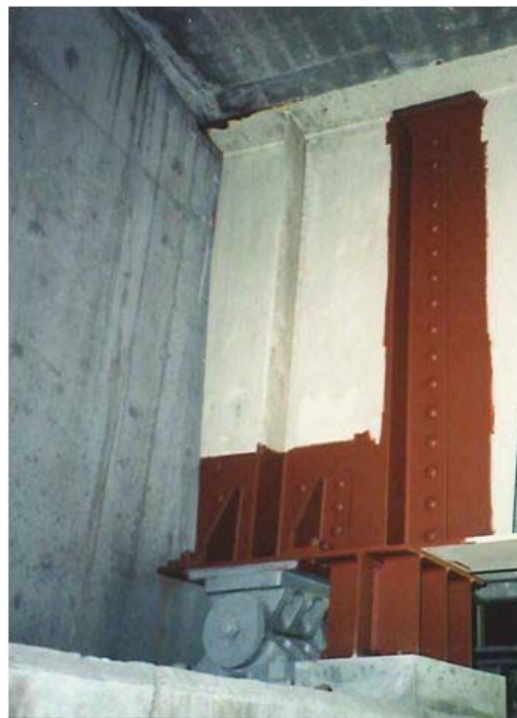
写真－7.6 支承交換時の主桁の補強
