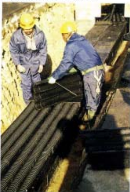
●構造体ユニット(上段)の布設
