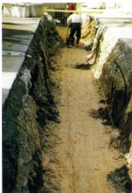
●構造体ユニット(下段)の布設
