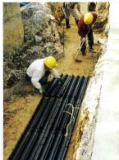
●構造体ユニット (下段)の布設
