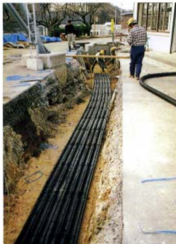
●構造体ユニット(下段)の布設
