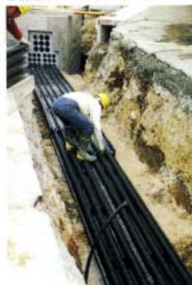
●構造体ユニット(中段)の布設
