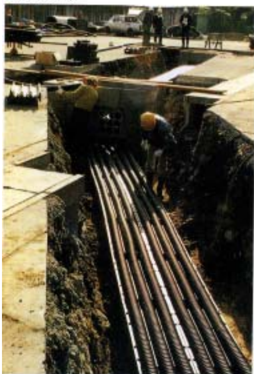
●構造体ユニット(上段)の布設
