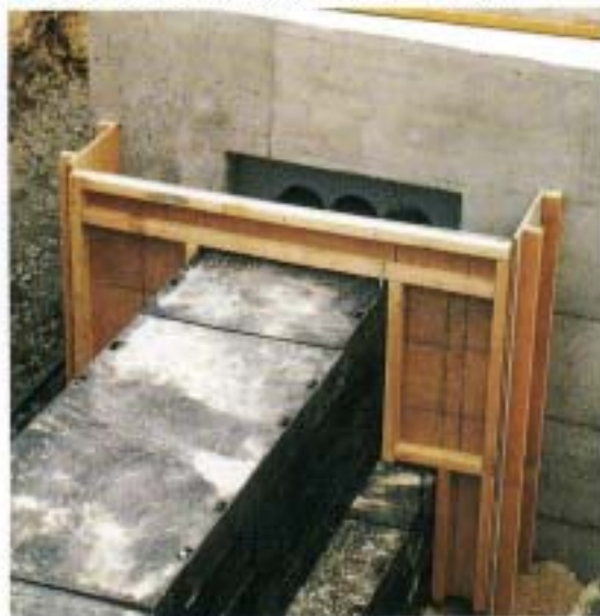
●マンホール取り付け部のコンクリート増し打ち
