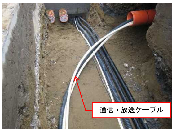
通信・放送ケーブルの引込状況
