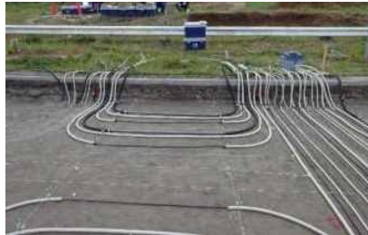
ケーブルを舗装に埋設
