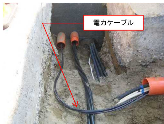
電力ケーブルの引込状況
