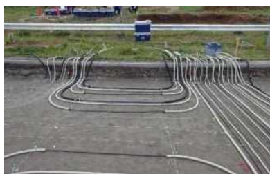
ケーブルを舗装に埋設
