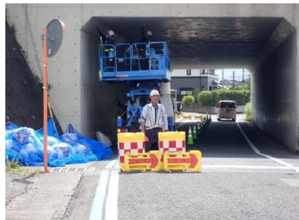
高所作業車等を用いたカルバートの目視・打音調査
