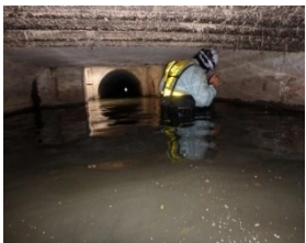
滞水した溝橋内部の目視点検
