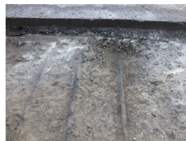
舗装を剥がしての 床版劣化(土砂化)の調査
