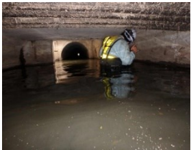
滞水した溝橋内部の目視点検
