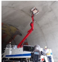
レーザー打音による変状の把握
