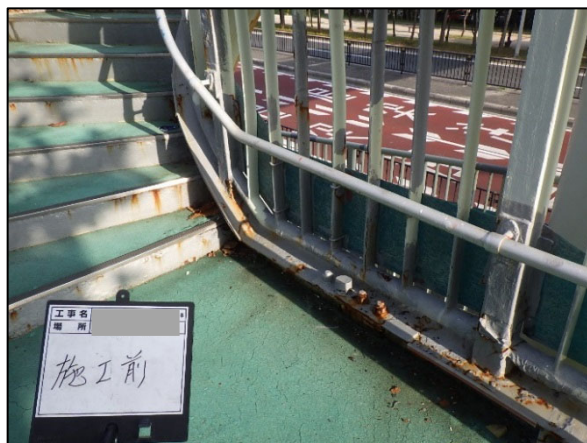
腐食損傷
