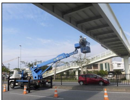
高所作業車による点検 （横断歩道橋）
