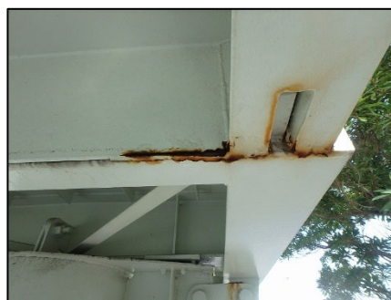
主桁_エッジ部の腐食 (横断歩道橋)
