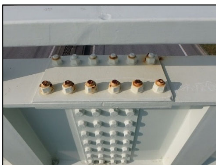
手すり_ボルト部の腐食 (横断歩道橋)
