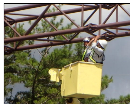
近接目視による点検 （門型標識）
