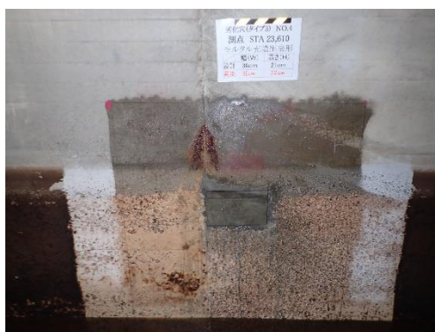
劣化穴補修後
