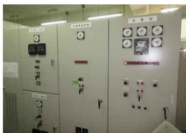
倉敷ダム電気設備改良予定箇所(受配電設備、警報装置、監視カメラ等)
