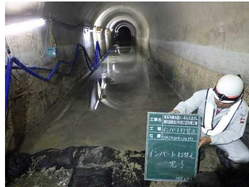
インバート補修完了
