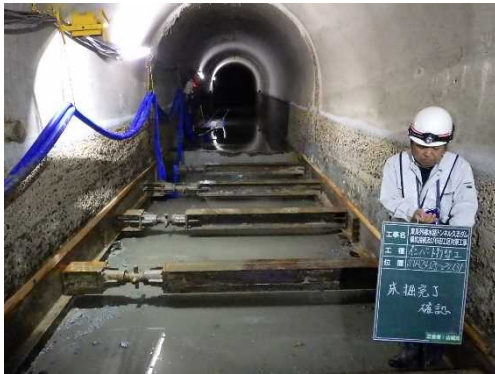
インバート打設前
