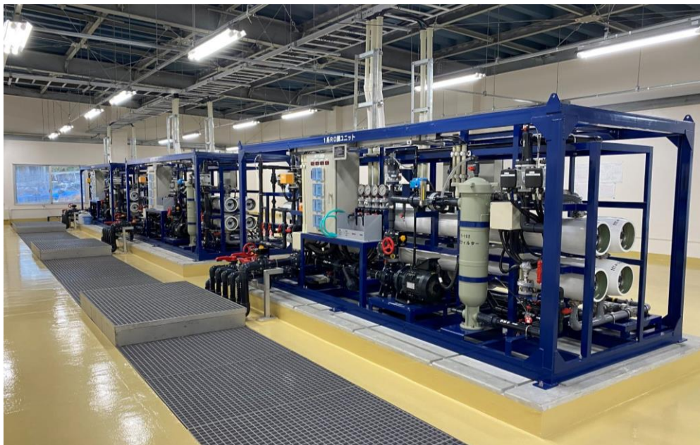
(写真) 企業局北大東浄水場の逆浸透膜設備
