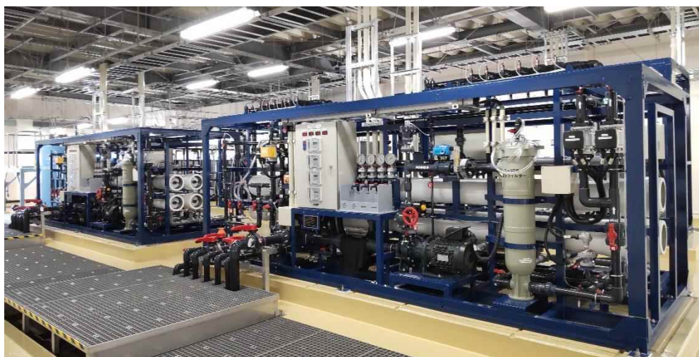
(写真) 企業局阿嘉浄水場全景(上)／企業局阿嘉浄水場の逆浸透膜設備(下)
