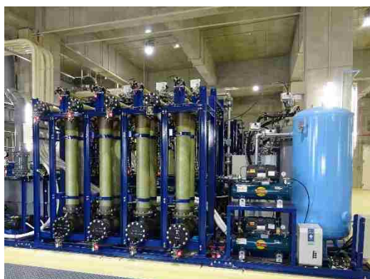
(写真) 沖縄県企業局伊是名浄水場全景(上) MF膜設備 前処理(左下)／逆浸透膜設備 後処理(右下)
