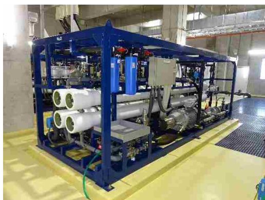
(写真) 沖縄県企業局伊是名浄水場全景(上) MF膜設備 前処理(左下)／逆浸透膜設備 後処理(右下)
