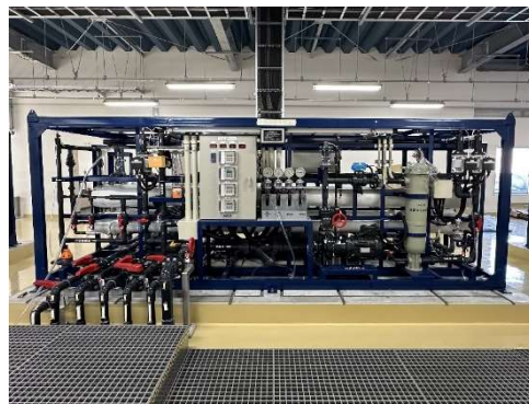
南大東浄水場 RO(逆浸透)膜設備
