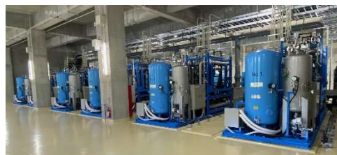
伊平屋浄水場 MF(精密ろ過)膜設備
