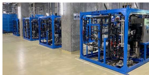
伊平屋浄水場 RO(逆浸透)膜設備
