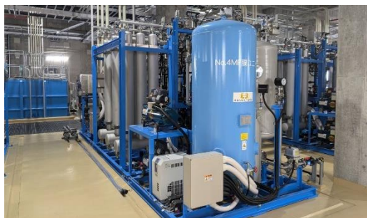
MF(精密ろ過)膜設備
