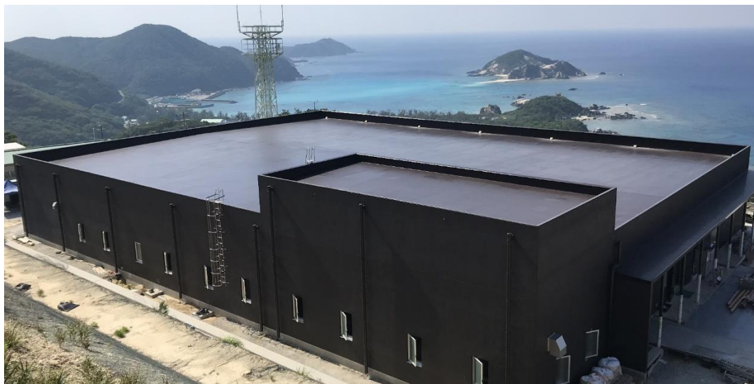
渡嘉敷浄水場 外観
