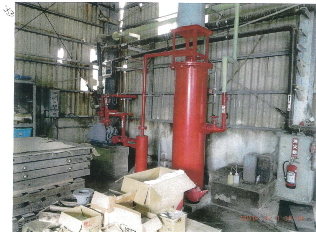
図8 昭和化学工業(株)様が保有していた水素出荷設備の分離器とルーツブロワーの外観
