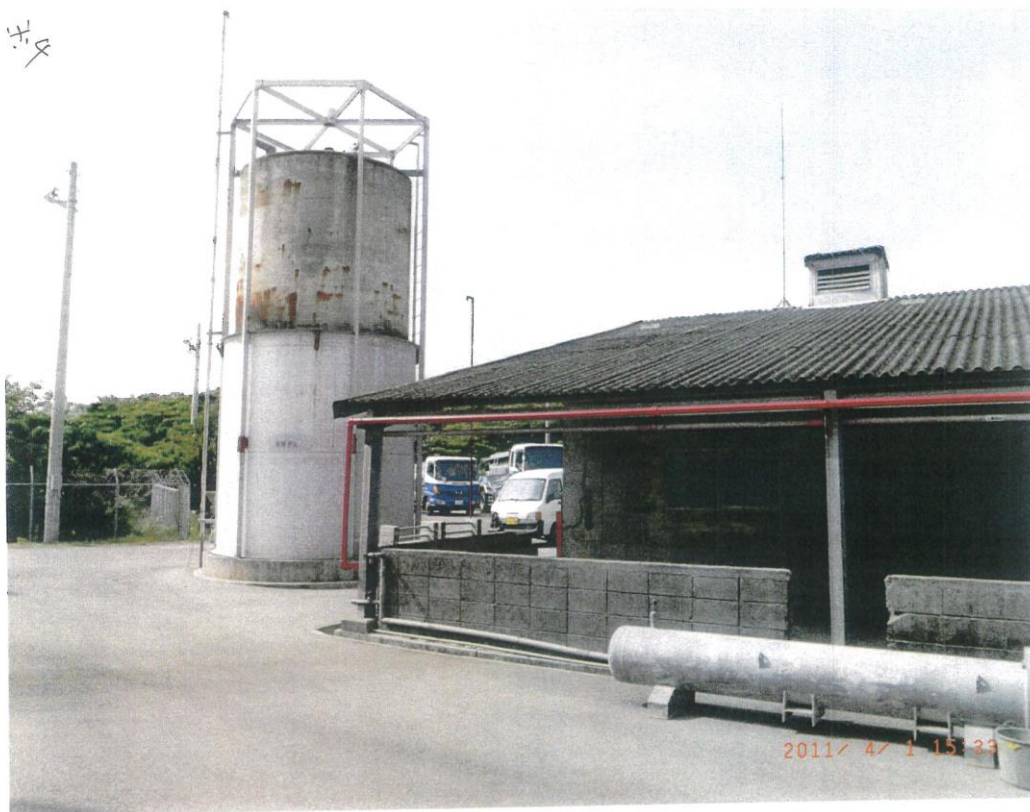
図9 昭和化学工業㈱様が保有していた水素出荷設備の有水式ガスホルダー(写真)
