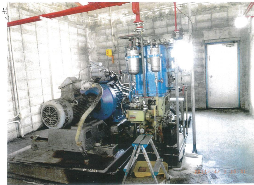
図 10 昭和化学工業が保有していた水素出荷設備の圧縮機の外観(写真)
