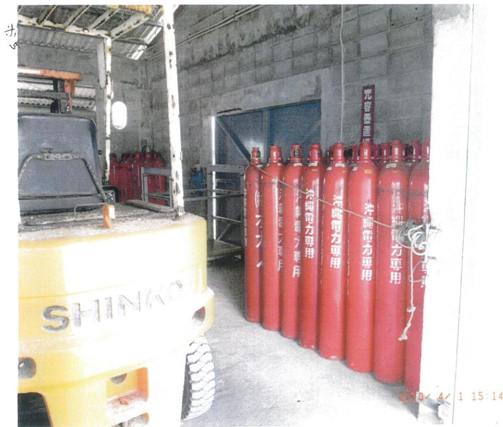
図 11 昭和化学工業㈱様が保有していた水素出荷設備のシリンダー充填場の外観(その 1) <写真>
