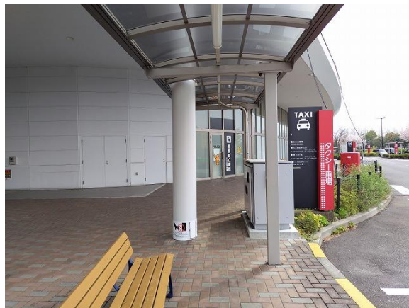
(d) 電源監視制御盤
