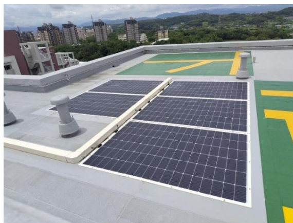
(d) 屋上平面部への設置
