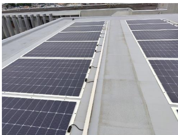
(c) 屋上平面部への設置
