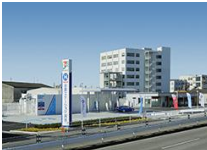
図 2.5 イワタニ水素ステーション愛知刈谷 (©岩谷産業株式会社)
