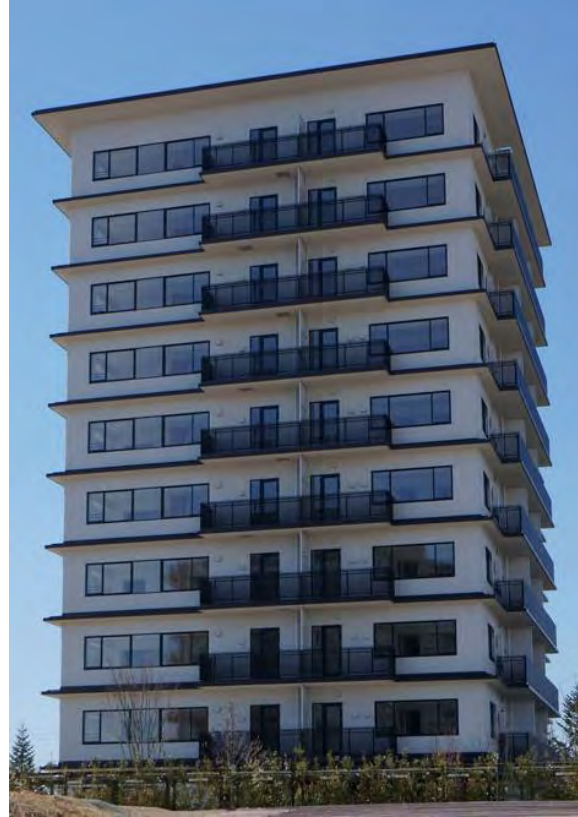
仙台で建設された10階建の 共同住宅(鉄骨+CLT+燃 エンウッド)
