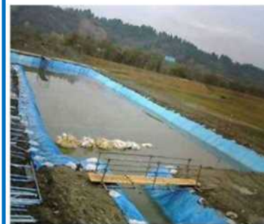
仮設沈殿池の設置例
